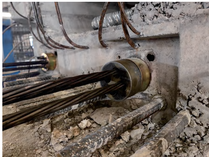
图5-1 现场预应力筋及锚垫板示意图
