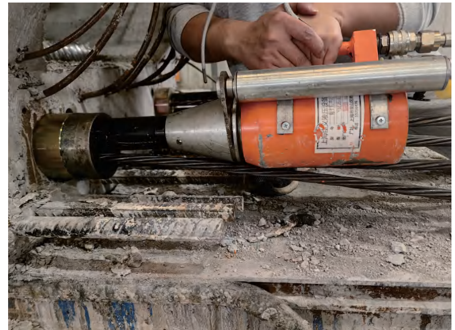
图5-2 千斤顶-锚垫板示意图
